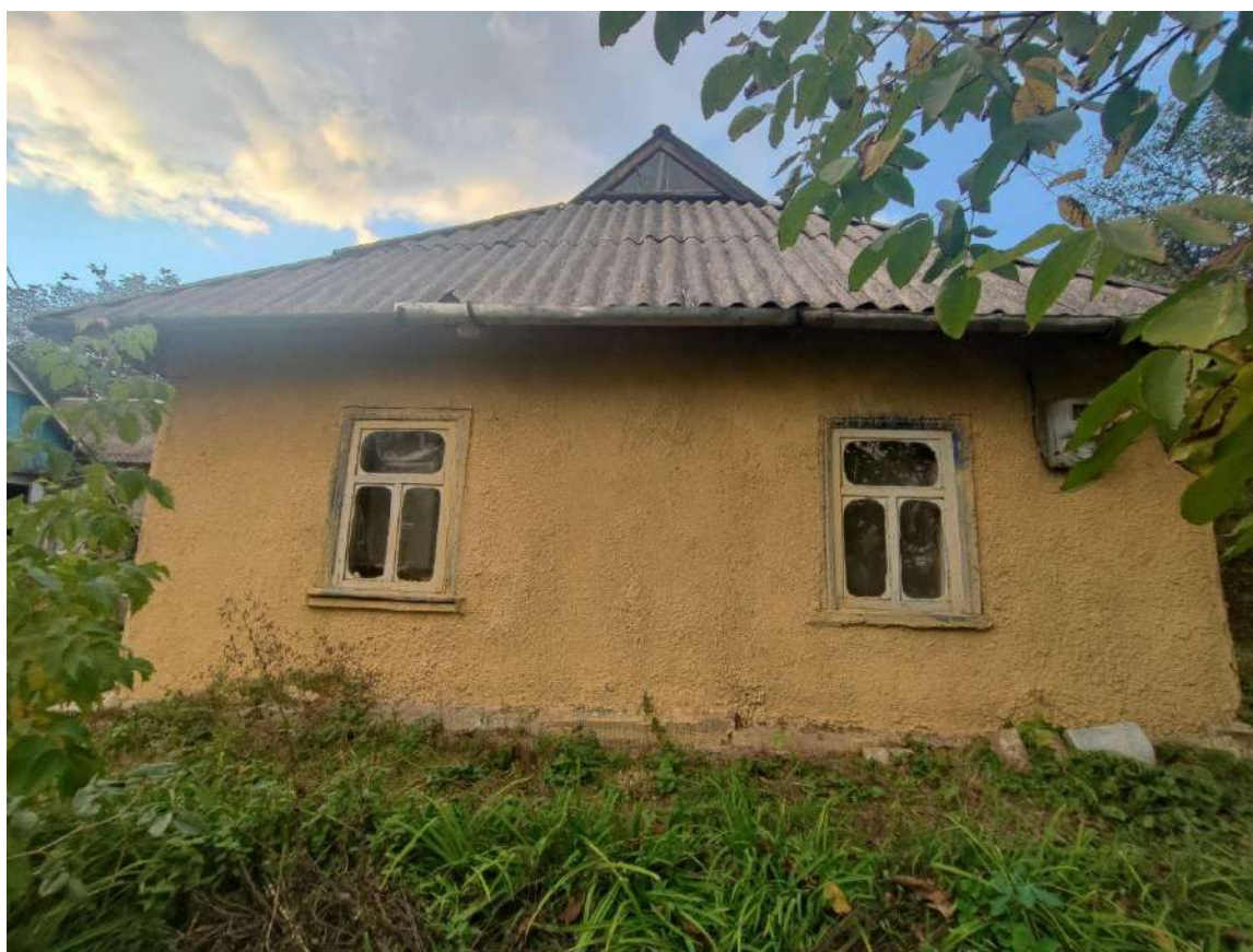
Рис. 2.3.2. Фотофіксація східного фасаду будинку
