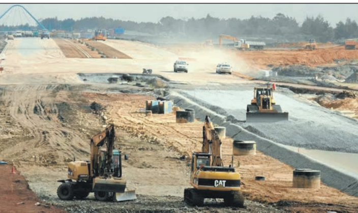
Будівництво доріг у межах реалізації програми Президента України «Велике будівництво». 2020 р.
