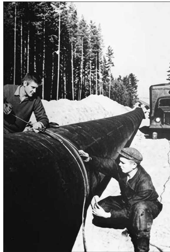
Будівництво газопроводу «Шебелинка—Острог». 1960 р.
